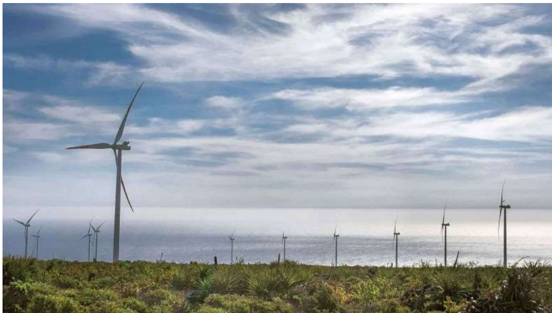
Stand 2021: Cururos Wind Farm Project in Chile, subventioniert von DHL GoGreen
